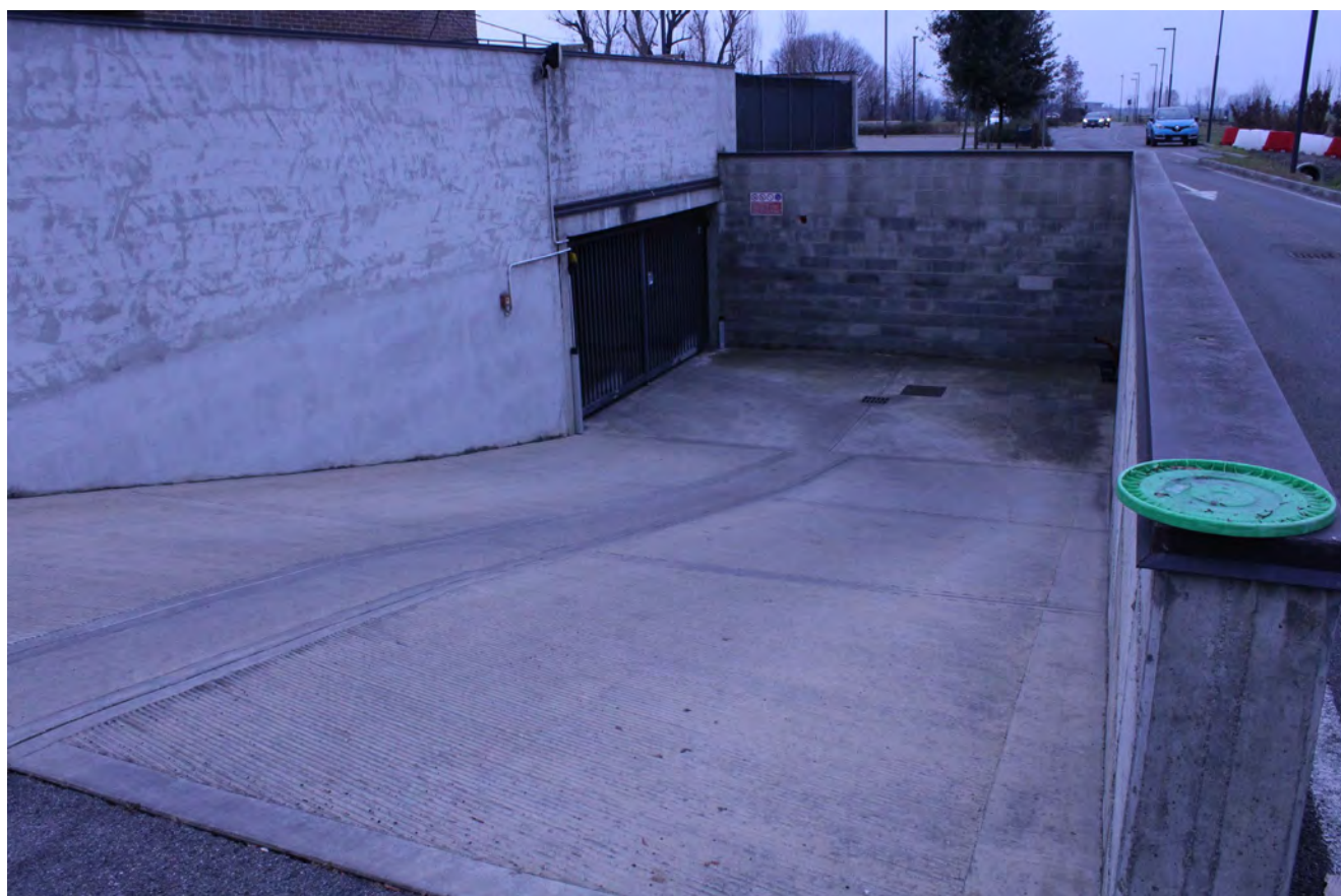
Rampa accesso piano interrato
