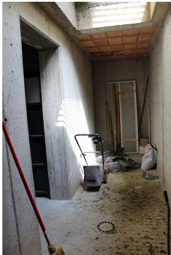
Intercapedine verso lato est
