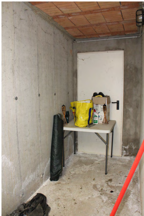
Intercapedine con porta verso vano scala
